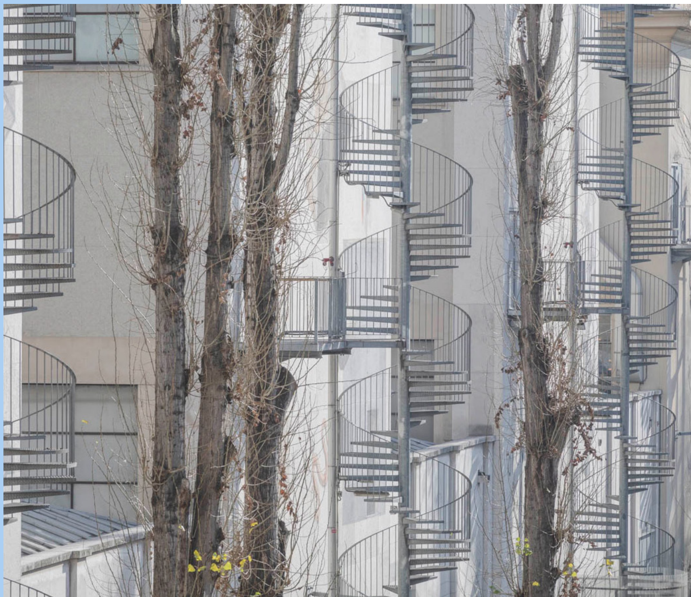
Vue du bâtiment depuis la rue de la Manutention, 2019
