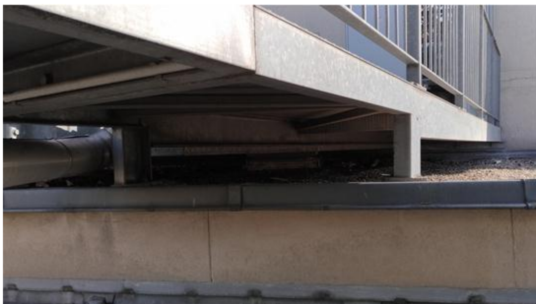
Architecture existante de la terrasse de l'espace Toguna
