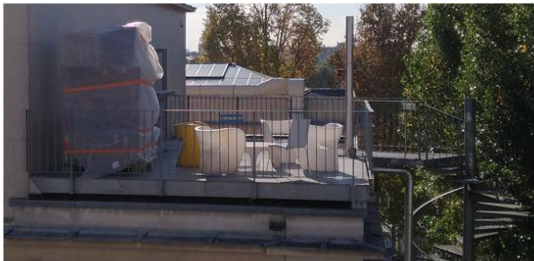
Partie existante de la terrasse de l'espace Toguna
